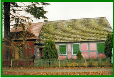
Haus vor der Sanierung
