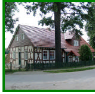
Haus nach der Sanierung
